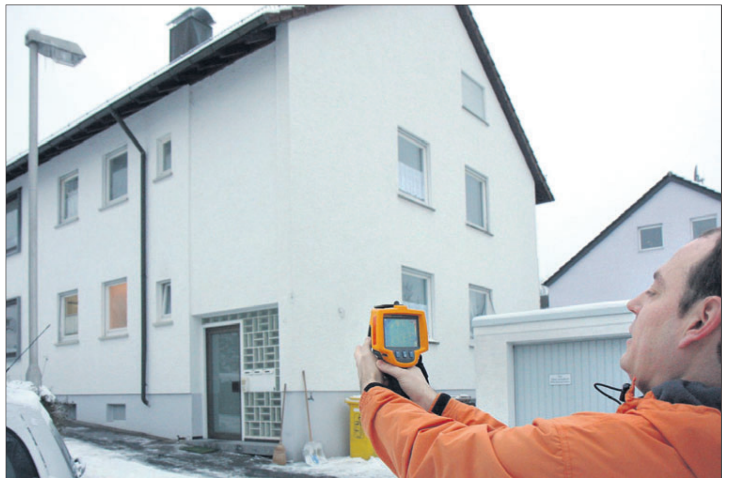
Der Bauphysiker und Energieberater Harald Haubensak macht eine Thermografieaufnahme vom Haus Wielandweg 4.
